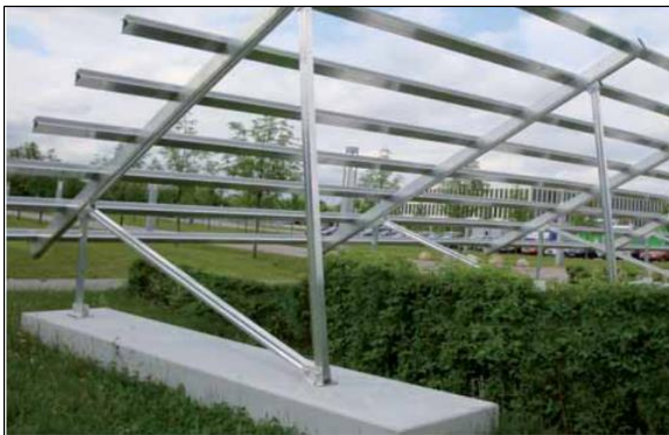
FIGURA 7 ESTRUCTURA APOYADA SOBRE BASES HORMIGONADAS
