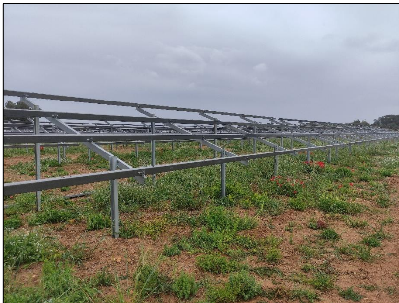
FIGURA 6 EJEMPLO DE ESTRUCTURA DE SOPORTE HINCADA
